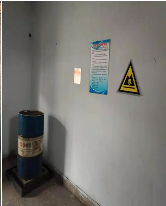
图 危废暂存间
